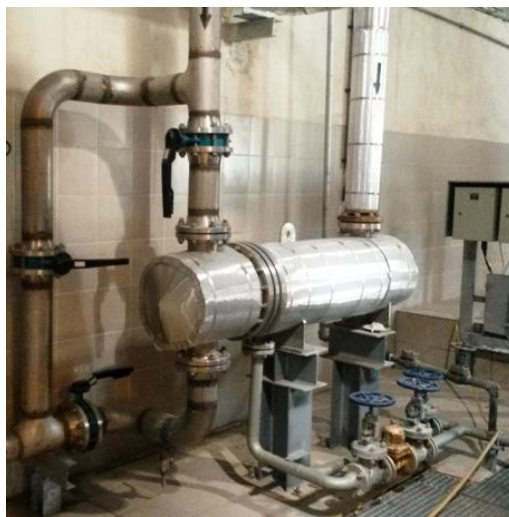
شکل 2. مبدل حرارتی پوسته-لوله.
