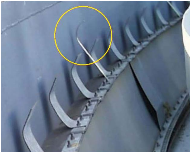
شکل ۱۰- هادی شانت و نحوه اتصال سقف شناور به دیواره مخزن [۱۳]
