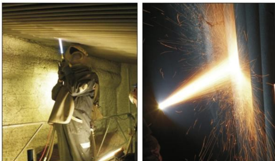
شکل 5- ایجاد پوشش ها به روش: HVOF و روش قوس الکتریکی روی عناصر بویلر [24]
