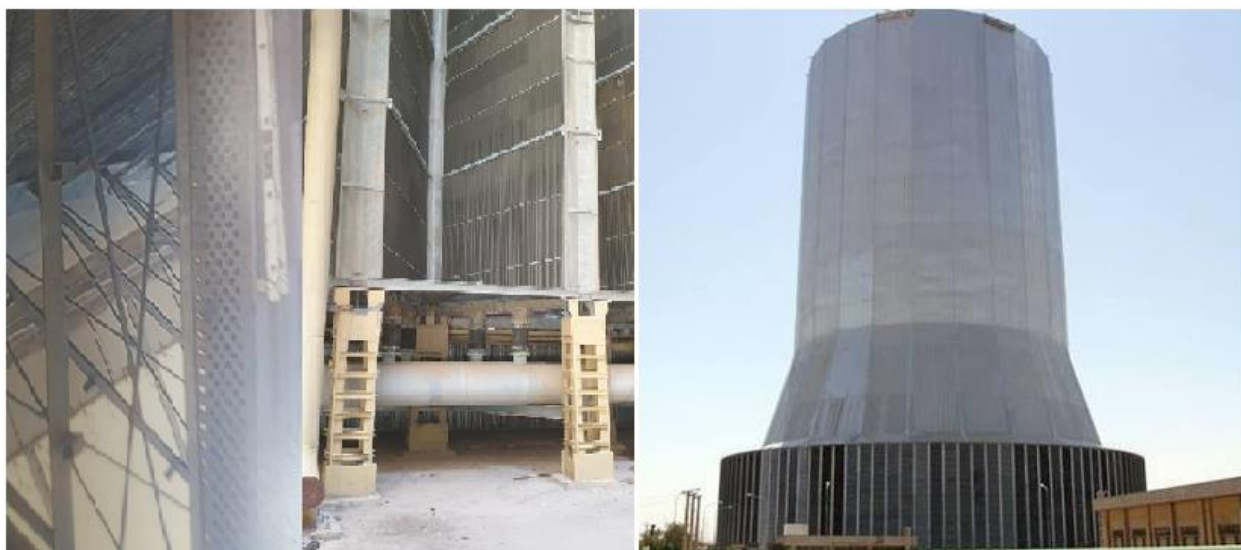
شکل ۳- برج خشک و نمای دلتا و نحوه قرارگیری لوله‌ها
