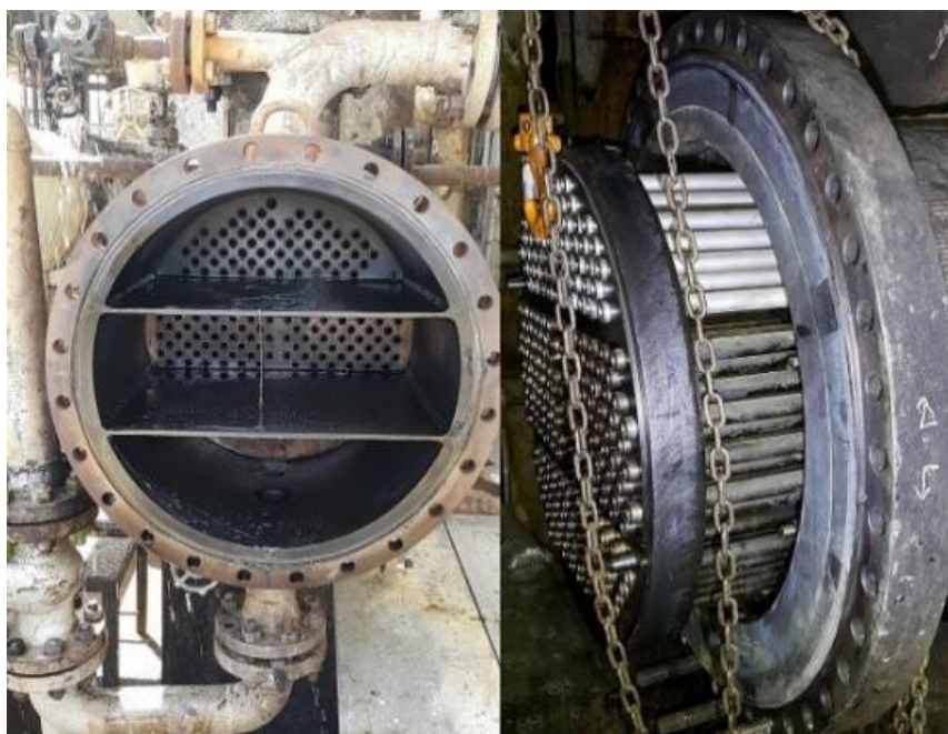
شکل 2- تعویض دسته لوله مبدل حرارتی نفت خام در پالایشگاه شیراز
